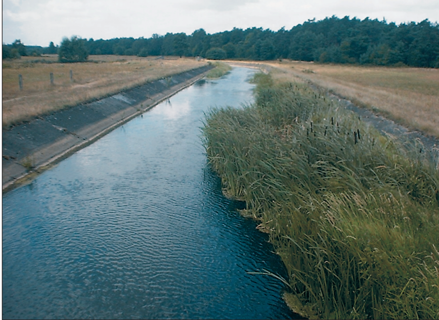
Fot. 1. St. 10 powyżej Zbiornika Słok. Po lewej stronie widoczny wybetonowany brzeg. Photo 1. Site 10 upstream of the Słok Reservoir. On the left side the bank covered with concrete is visible.
